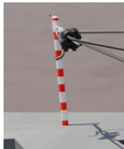
带预埋筋的立柱锚固
