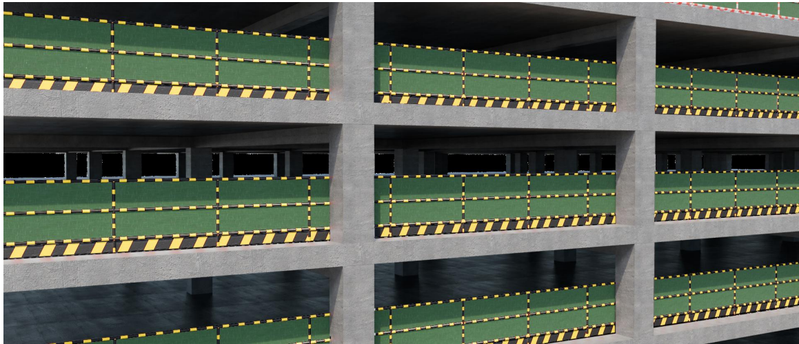
楼层边钢管式防护
