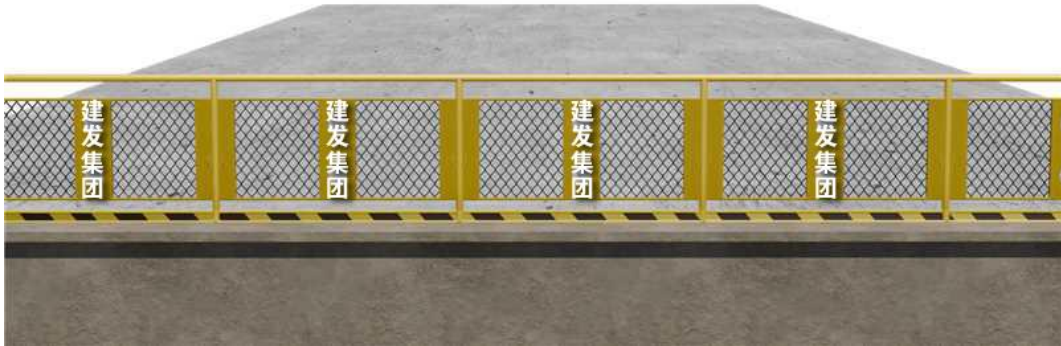
场地已硬化定型化防护
