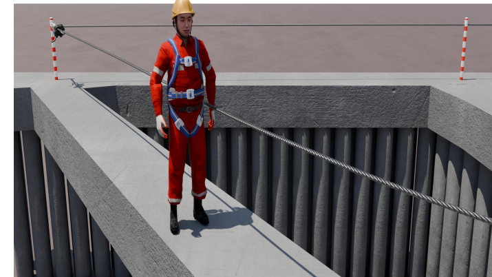
基坑内支撑梁钢丝绳设置示意图
