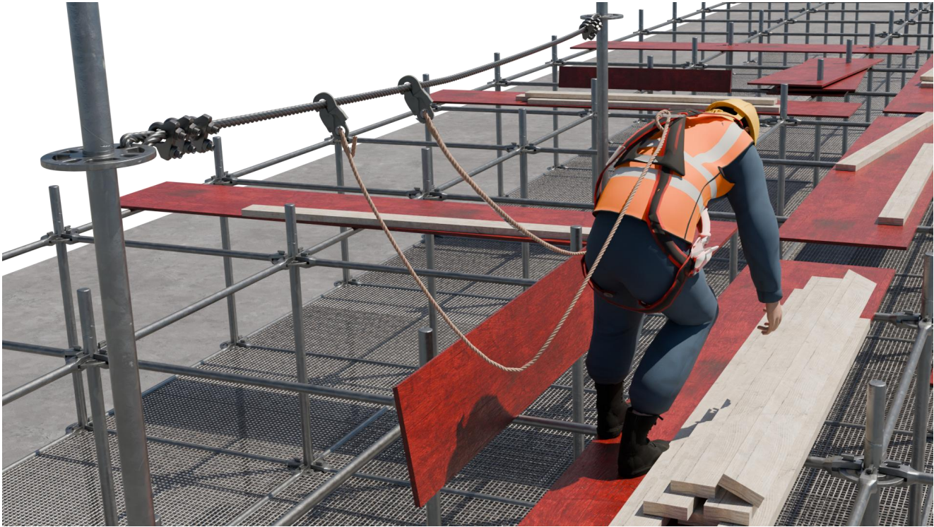
模板搭设作业安全带系挂点
