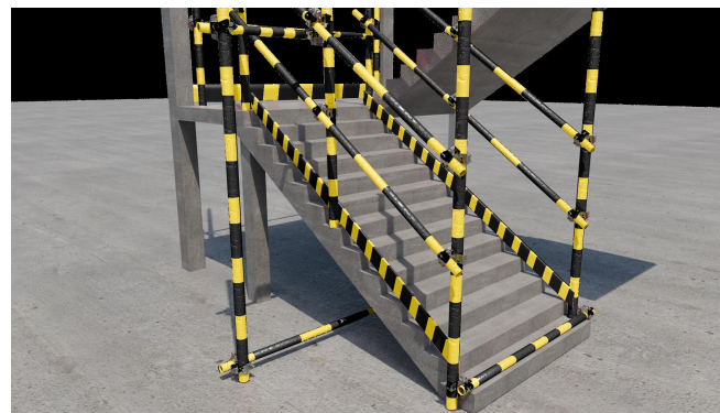
楼梯间钢管扣件式防护护栏
