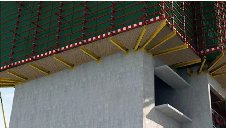
悬挑架悬挑层封闭式防护
