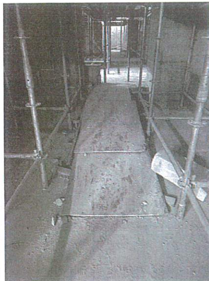
斜坡通道木板未钉设牢固，未钉设防滑木条
