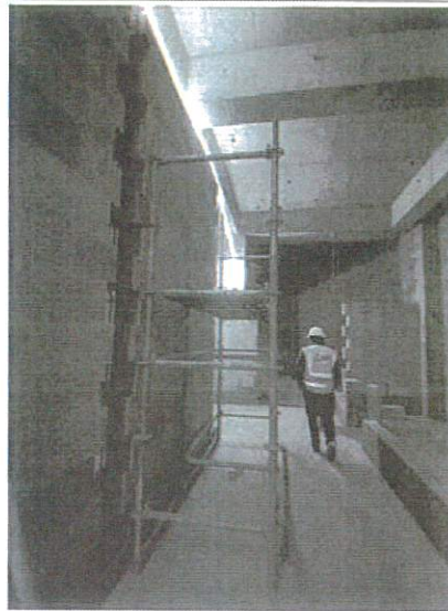
移动脚手架安全防护栏杆设置不到位、钢脚手板未满铺、缺少斜拉杆、水平杆和人员登高扶梯，且未验收挂牌
