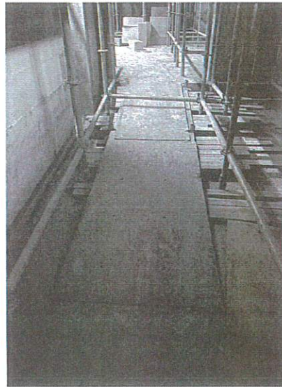
斜坡通道木板未钉设牢固，未钉设防滑木条
