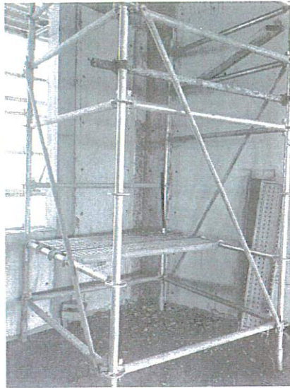
钢脚手板未满铺、随意使用木方，安全防护栏杆高度不足 1.2 米 缺少水平杆且未验收挂牌
