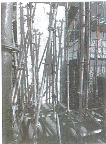
PC 墙板斜撑未固定牢固
