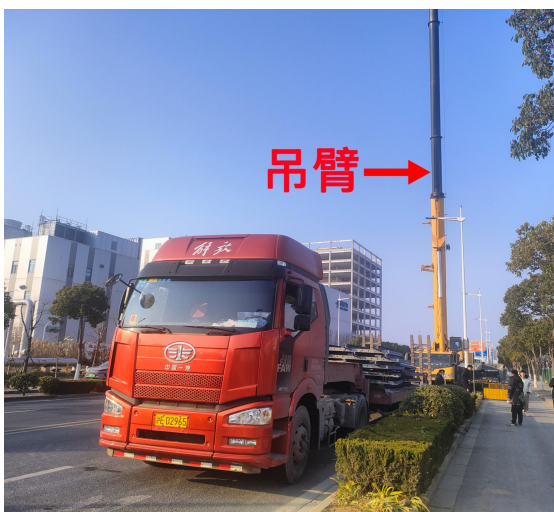
图 2 吊装作业现场图
